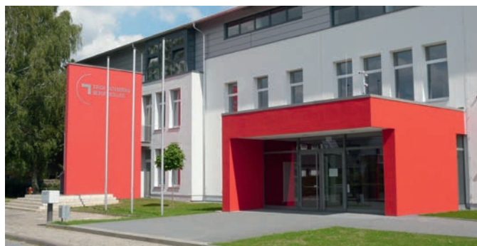
Eingangsbereich nach Sanierung und Aufstockung
