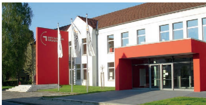
Eingangsbereich vor der Sanierung
