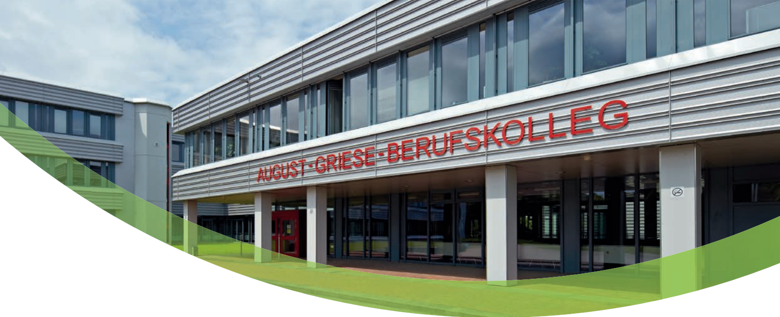
Eingangsbereich nach der Sanierung
